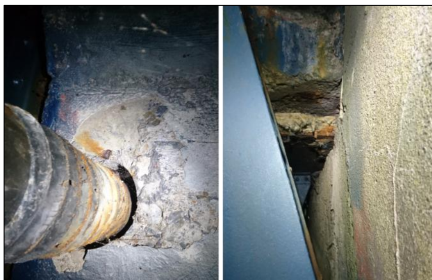
Abb. 3: Potentielle Quartiermöglichkeiten für Fledermäuse an der Okerbrücke
