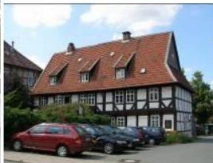
Links: Sog. Senioratskurie Rechts: Kuriengebäude „Hagenscher Hof“
